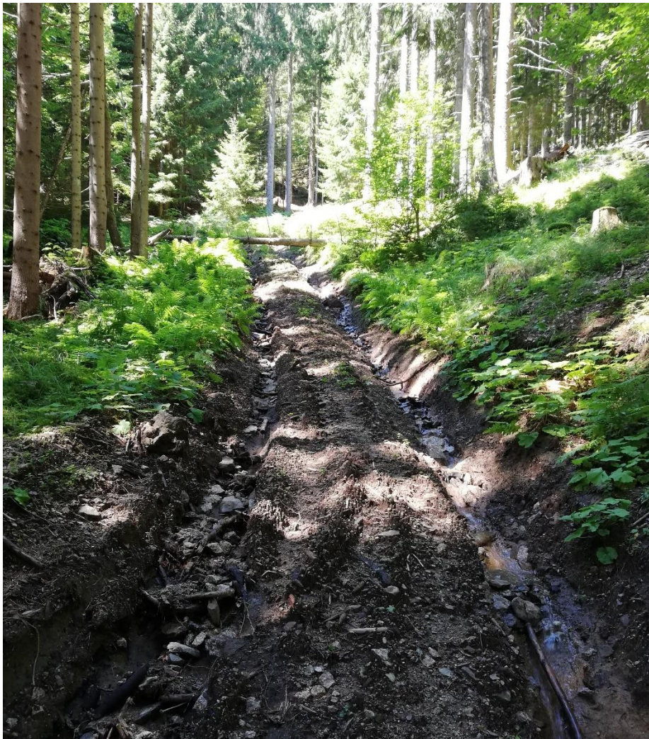
Slika 2: Vsak ki ima pravico uporabljati gozdne vlake jih ima pravico (po uporabi pa dolžnost) tudi vzdrževati. Zagotavljanje ustreznega odvodnjavanja in prevoznosti vlake sta ključni za dolgoročno zagotavljanje njene namenske rabe.
