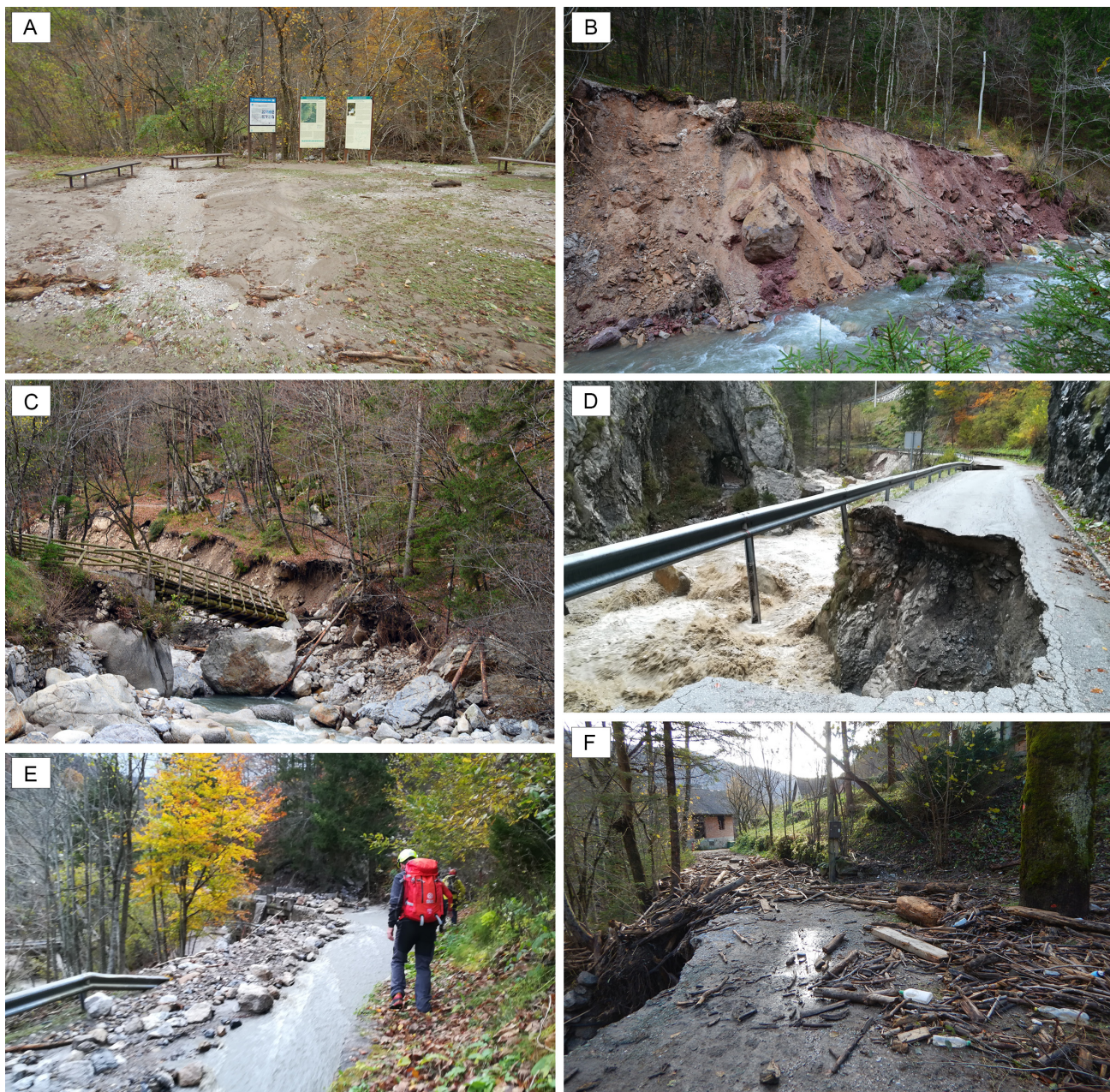
Sl. 3. Posledice ujme v Dovžanovi soteski: A) poplavljená ravnica v Čadovljah; B) erodiran desni breg Tržiške Bistrice in poškodbe sprehajalne poti pri Čadovljah; C) erodiran desni breg in podrt most pred vhodom v Dovžanovo sotesko; D) udori ceste na erodirani brežini; E) kamninski drobir s Kušpegarjevega plazú; F) lesno plavje na cesti v Dolini (D, E: foto Primož Štamcar, GRS Tržič).
