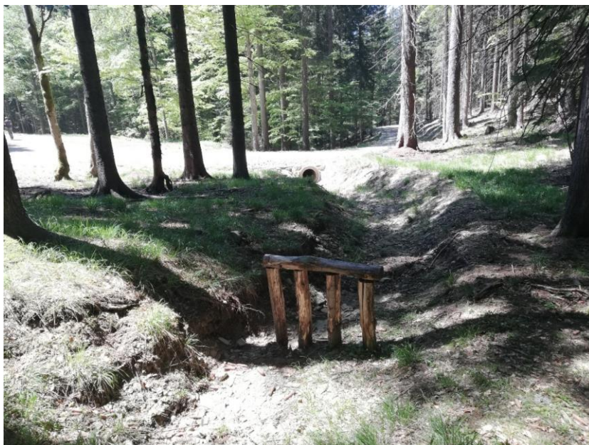
Slika 4: Primer manjšega prebiralnega objekta, ki služi zaščiti cevnege prepusta na gozdni cesti pod Ratitovcem (Foto: Saražin J.)
