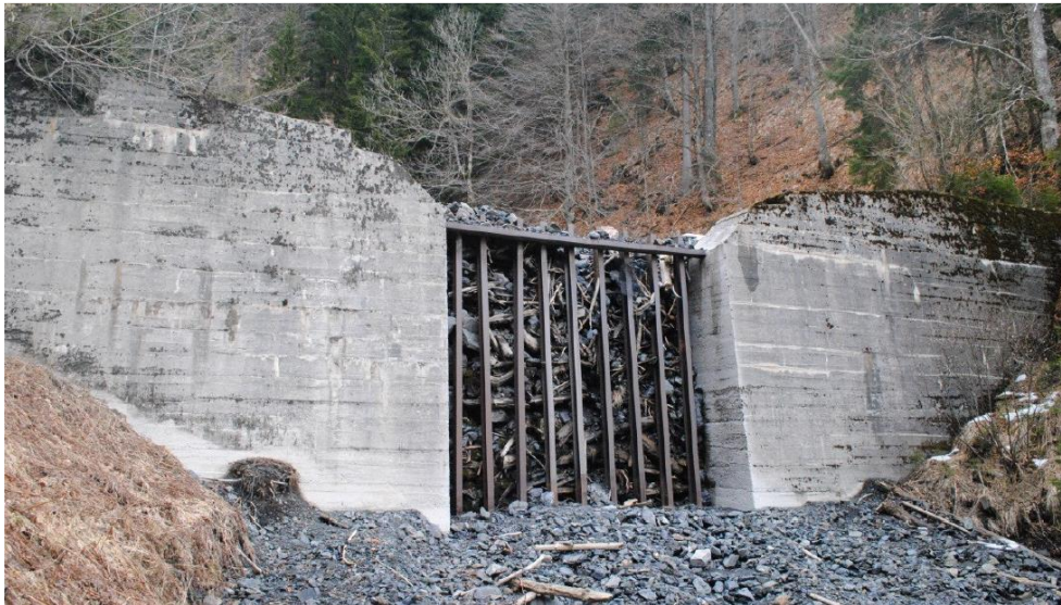
Slika 2: polna prebiralna pregrada na hudouriku Suhelj (Turel, 2021)
