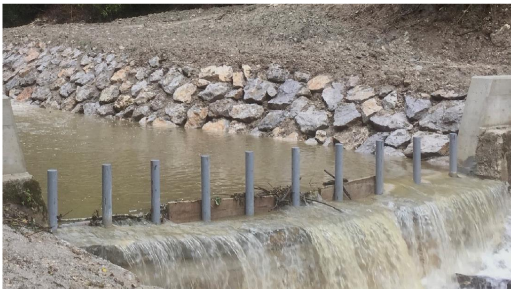
Slika 3: zaplavna pregrada z vgrajenimi konstrukcijskimi lovilnimi elementi na prelivu pregrade na Kolovratščici (Foto: Kobal M. v: Turel, 2021)
