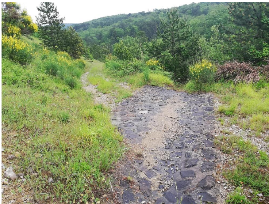
Slika 8: utrjena mulda na gozdni vlaki
