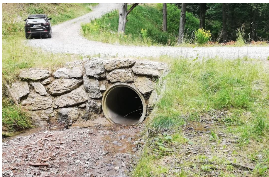
Slika 6: Večji cevni prepust na gozdni cesti
