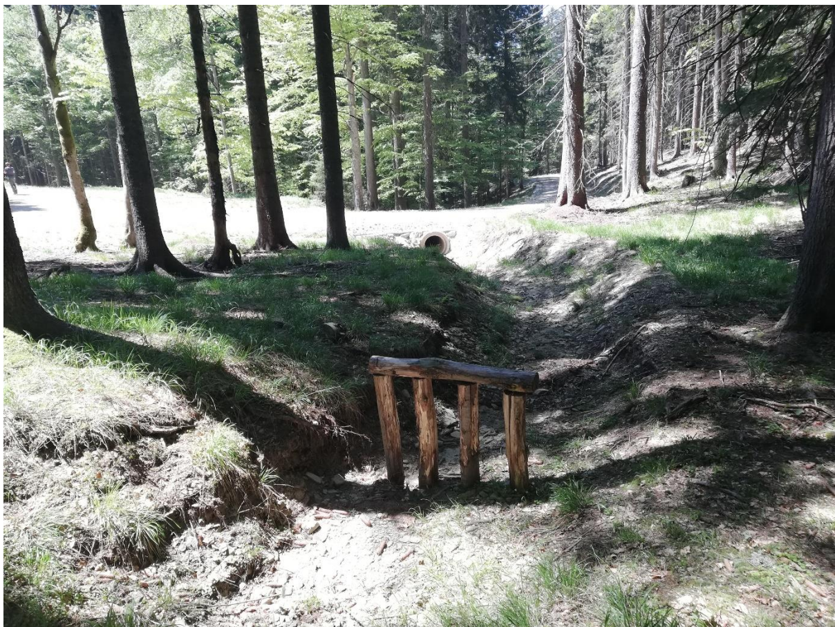
Slika 5: enostaven lovilni element nad cevnim prepustom gozdne ceste, namenjen prestrazanju plavja
