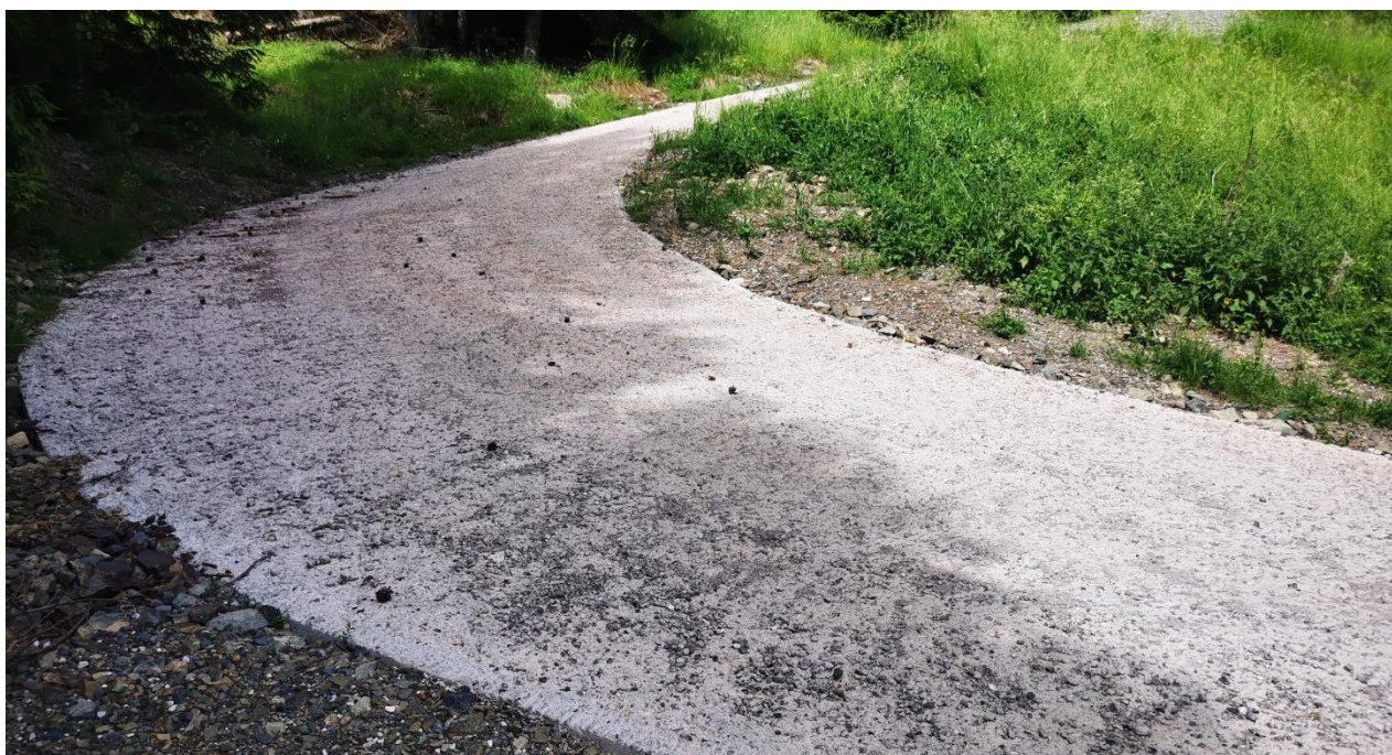
Slika 13: Betonska voziščna konstrukcija.
