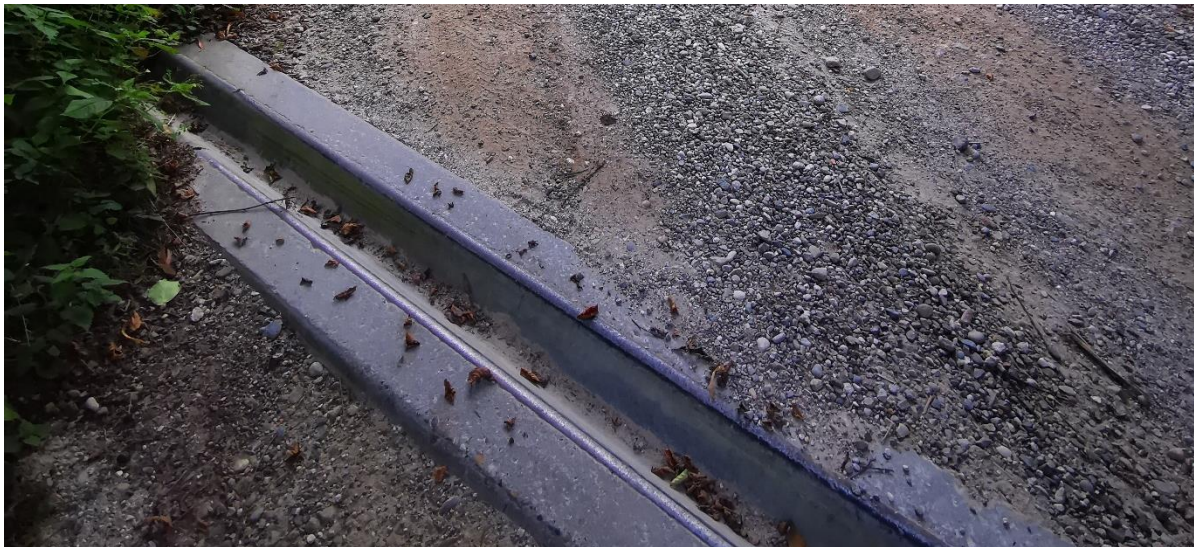
Slika 7: Vbetoniran dražnik v obliki črke V.
