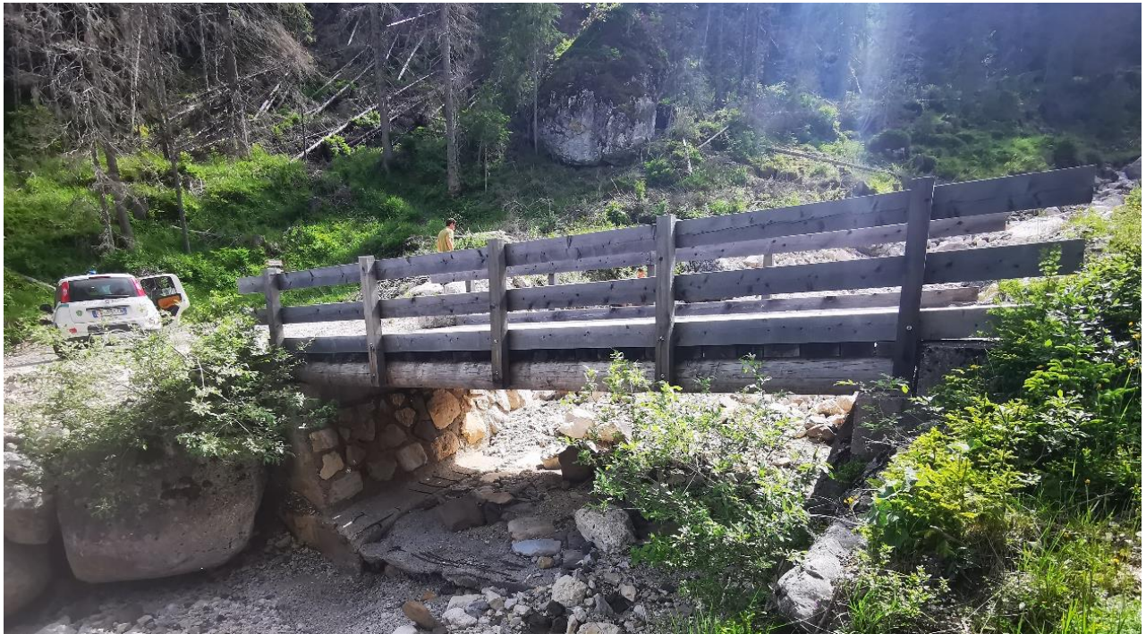
Slika 14: Izvedba mostu na gozdni cesti.
