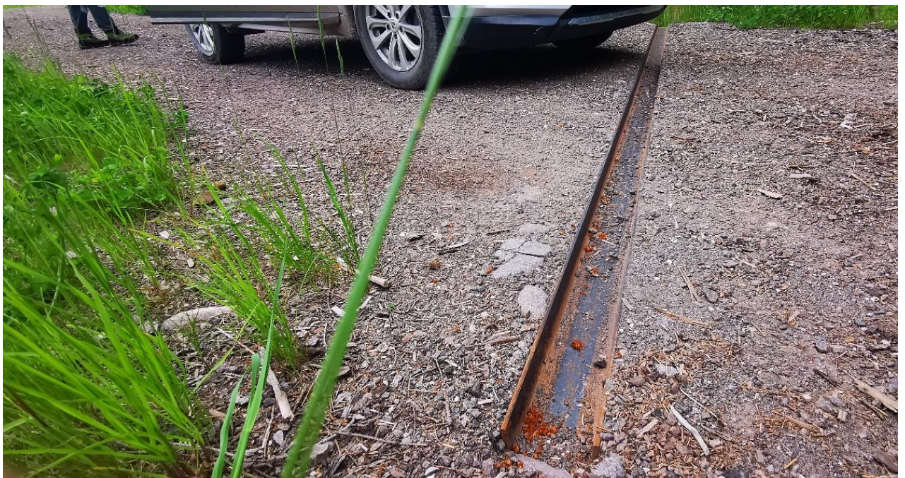
Slika 15: Za prečno odvodnjavanje uporabljajo kovinske dražnike.
