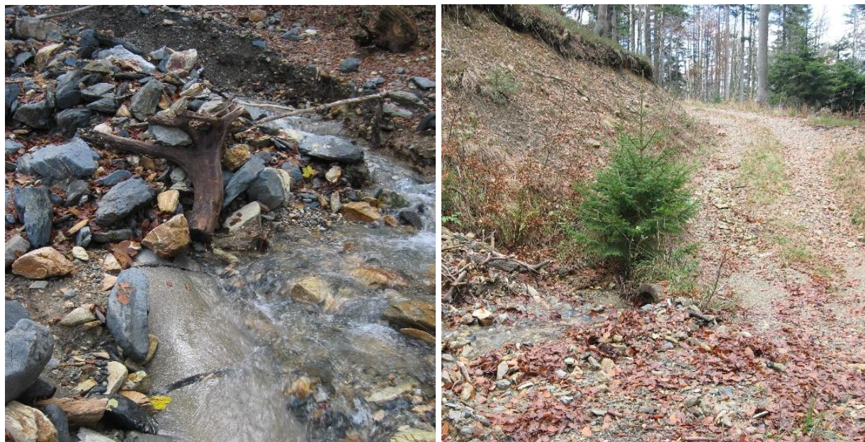
Slika 8: Zamašena cevna prepusta na gozdnih vlakah (foto: Smolnikar P.)
