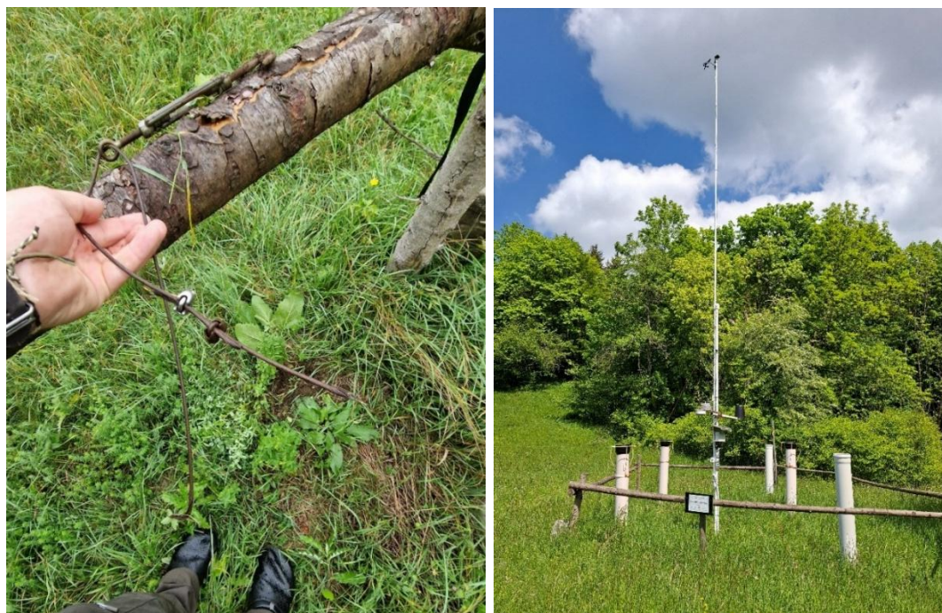
Slika 112: Poškodba ene od treh jeklenic, ki stabilizirajo meteorološko postajo Fondek na Trnovski planoti (levo, september 2025) (Foto: M. Šuligoj), in meteorološka postaja po izvedeni sanaciji (desno, oktober 2025) (Foto: M. Rupel).
